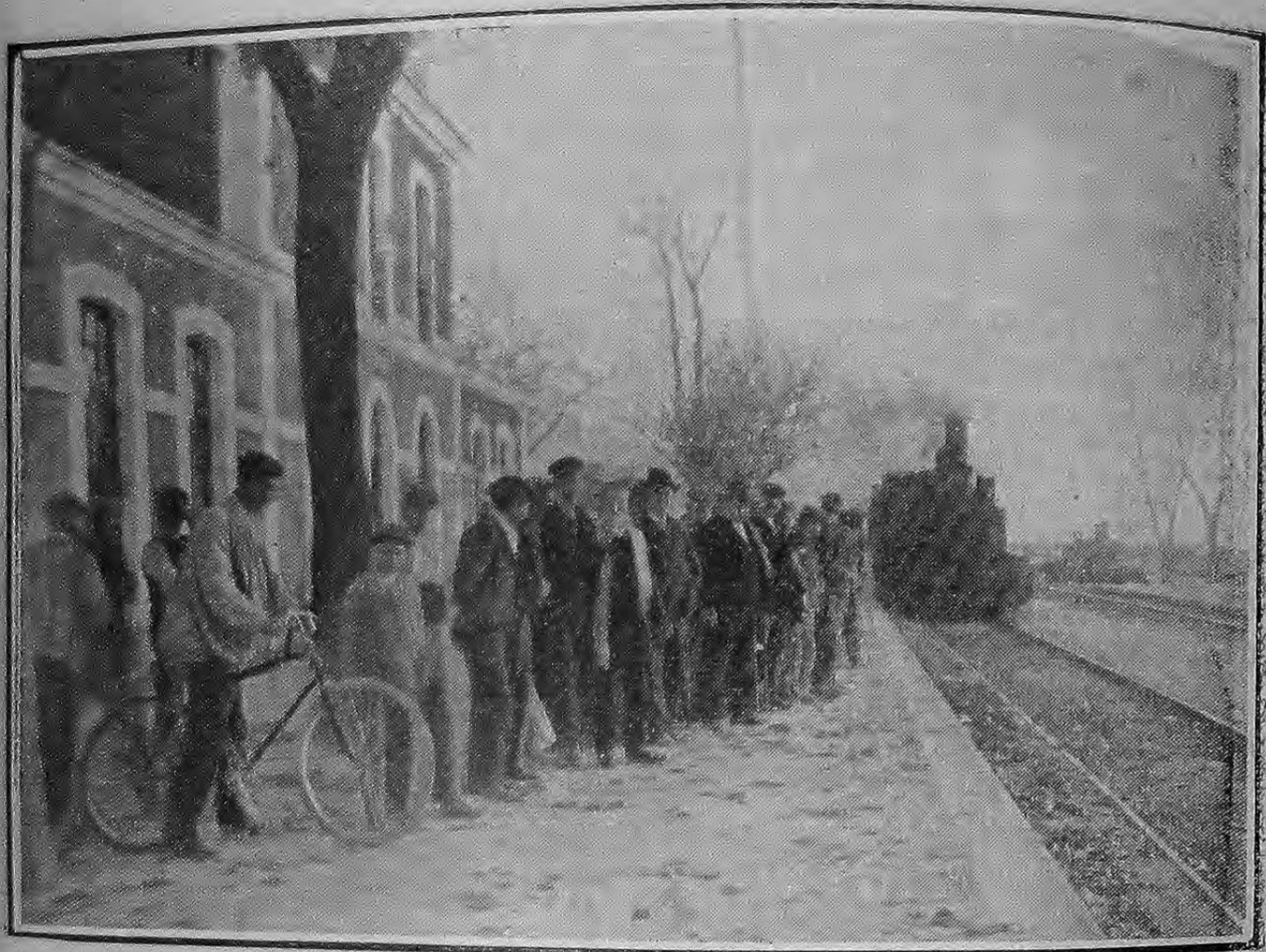
Estación de Mora.
